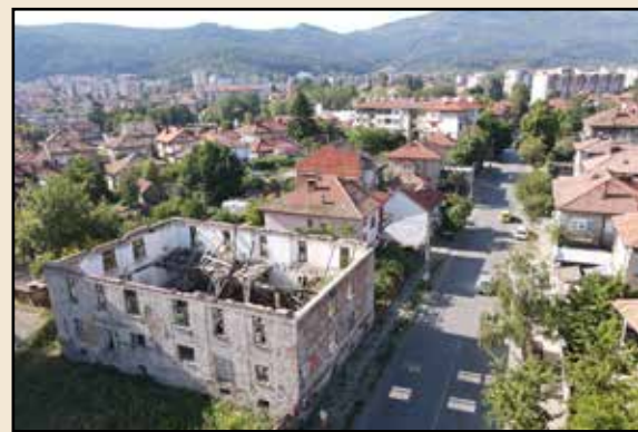
Изглед отгоре на склад № 3, Тютюнев монопол, намиращ се в близост до Цирковата площадка
